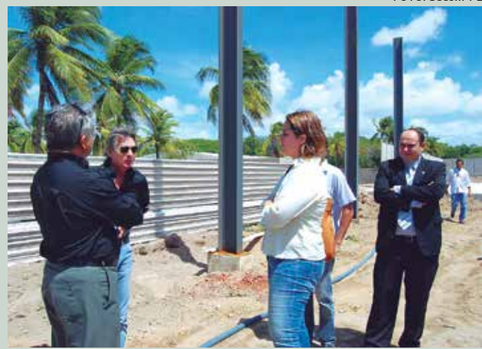
Secretário visita obras de construção da nova sede da AcaDepol
